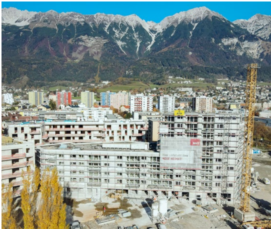
Die Arbeiten am aktuell größten städtischen Bauprojekt in der Reichenau laufen auf Hochtouren.
