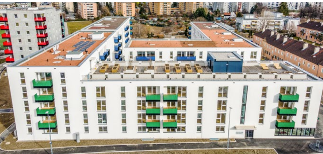
Im Stadtteil Pradl-Ost wurden am Standort der alten Südtiroler Siedlung kürzlich 142 neue Wohnungen fertiggestellt und übergeben.
