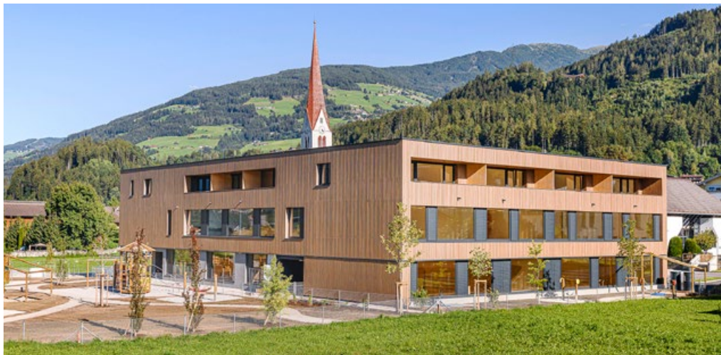
Ein echtes Schmuckkastl: das neue Mehrgenerationenhaus in Volders.
