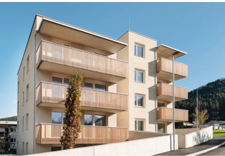
Klein und fein: Auf einem Grundstück des Stiftes Wilten wurde im Herbst eine Wohnanlage mit zwölf Mietwohnungen fertiggestellt und übergeben.
